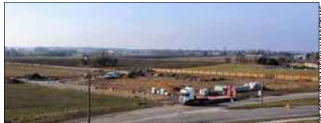
Budowa ulicy Zbożowej w Parczewie idzie pełną parą. Za niespełna miesiąc droga ma być gotowa do użytkowania
