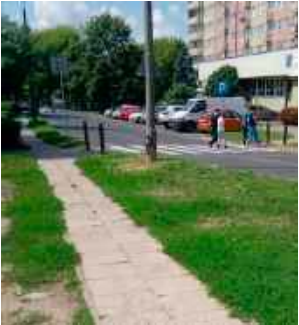
Chodnik przed i po remoncie
