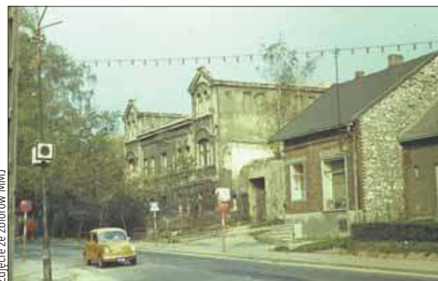
Zrujnowany budynek kociego zamku pod koniec lat 70. XX wieku
