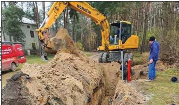
Wykonano 1,4 km z planowanych 2,4 km sieci wodociągowej
