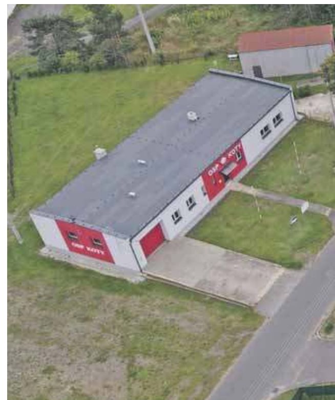
Poddana termomodernizacji remiza Ochotniczej Straży Pożarnej w Kotach
