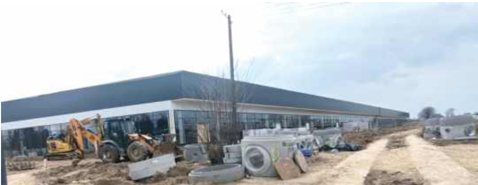
Targowa Park - plac budowy, kwiecień
