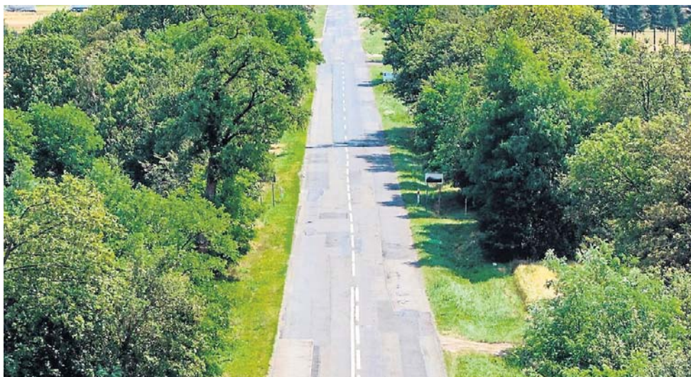
Odcinki dwóch dróg wojewódzkich nr 482 i 486 w naszym regionie zostaną wyremontowane
