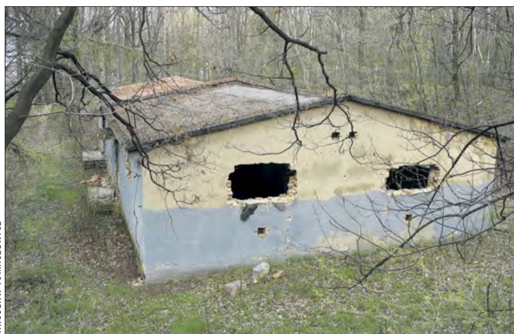
Nieistniejące już budynki magazynowe zbudowano na przełomie lat 50. i 60. XX w.
