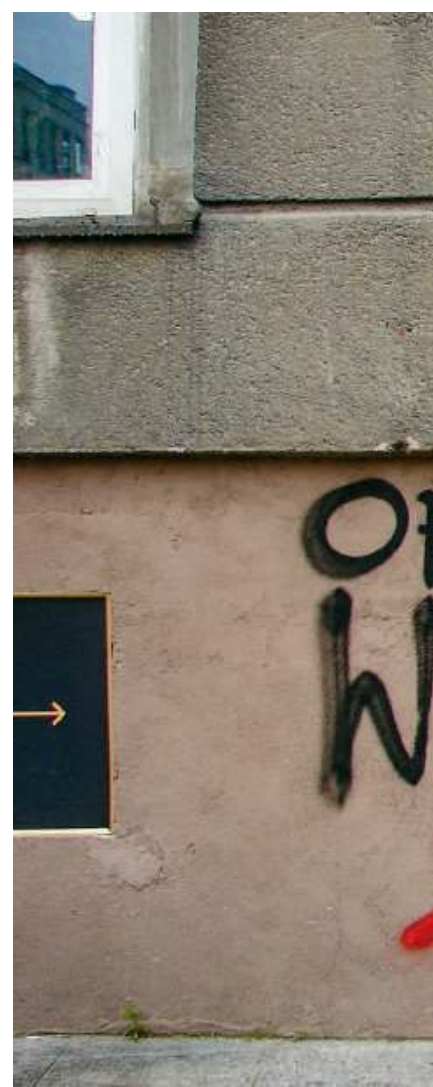
Napis wykonany na fasadzie gmachu PAST-y przy ul. Zielnej 39.
