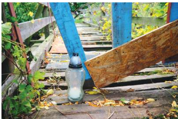
Kładka, na której doszło do śmiertelnego wypadku
