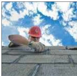
Do wnoszenia murów, kiedy na dworze panuje temperatura poniżej 0 stopni Celsjusza, należy zastosować zimową zaprawę
