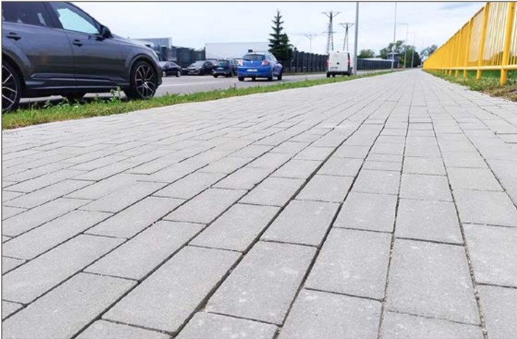
Według dyrektora kostka leży na podstawie cementowo-piaskowej.
