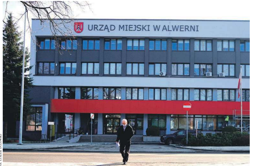
Odnowiony budynek Urzędu Miejskiego w Alwerni
