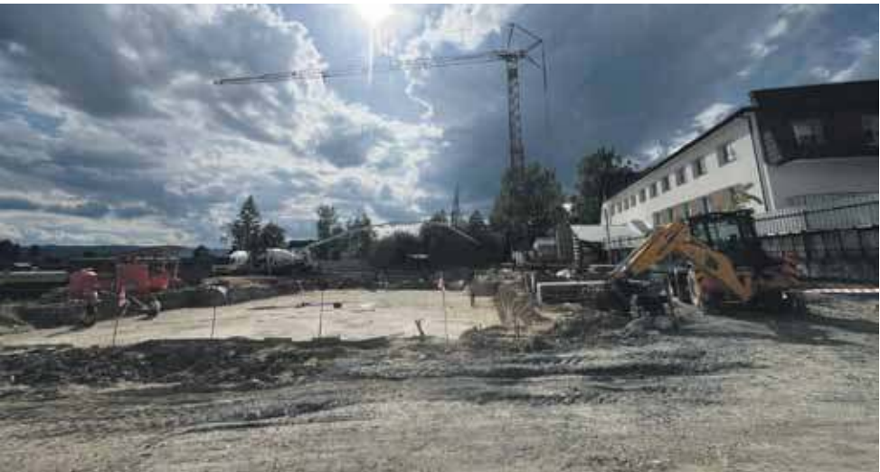
Budynek wielorodzinny ma powstać w ciągu dwóch lat.
