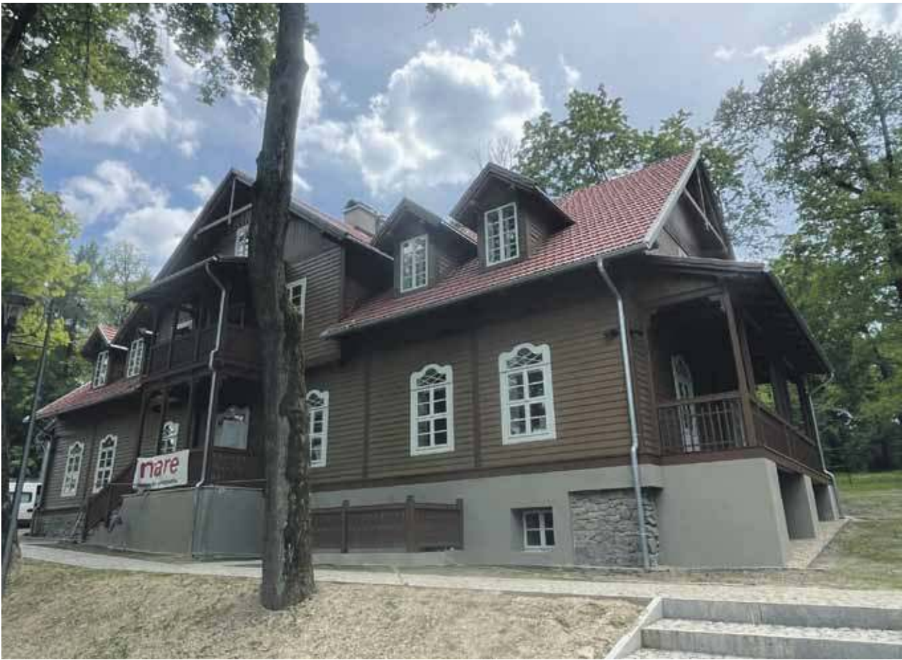
Odbudowana po pożarze willa „Anioł”.
