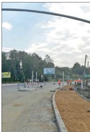
Ostatecznie całkowity remont ul. Jastrzębskiej ma się zakończyć w październiku przyszłego roku.
