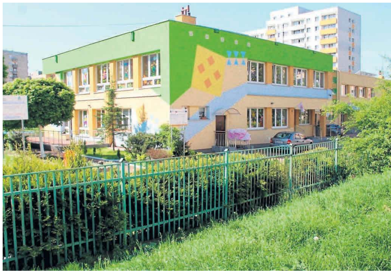
W poniedziałek, 11 maja, otwarte zostało w Będzinie m.in. Przedszkole Miejskie nr 13 im. Juliana Tuwima na osiedlu Syberka
