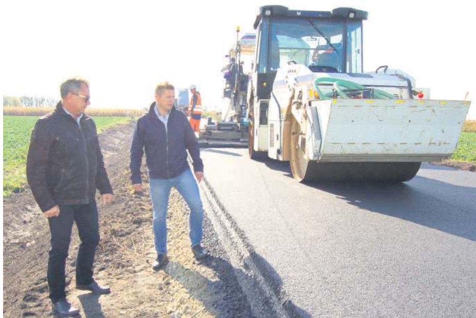
Nad postępowaniem prac czuwał specjalista ds. inwestycji w Powiatowym Zarządzie Dróg w Strzelinie Bogdan Sokołowski (z lewej) i dyrektor PZD Zdzisław Ziąber
