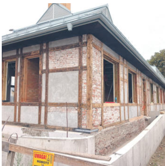
Dworzec w trakcie prac remontowych
