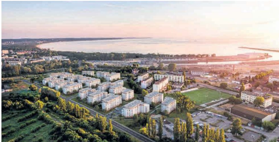
Na 5-hektarowej działce w Nowym Porcie w ciągu 5. lat stanie 16 budynków (1200 mieszkań)
