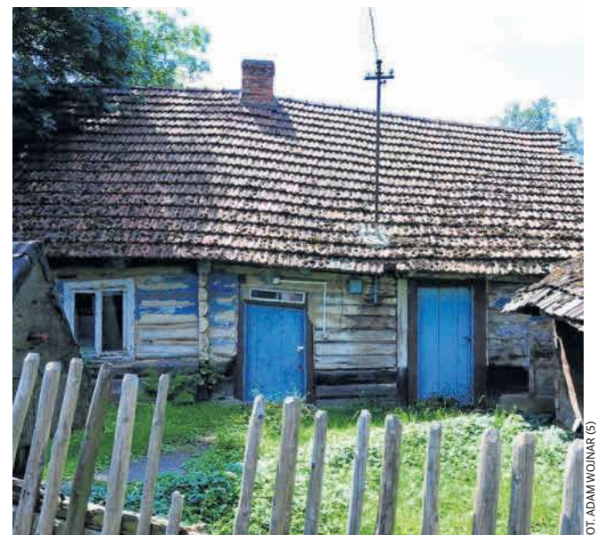
To jedna z urokliwych - ale w fatalnym stanie technicznym - chałup w Mogile (część Nowej Huty)
