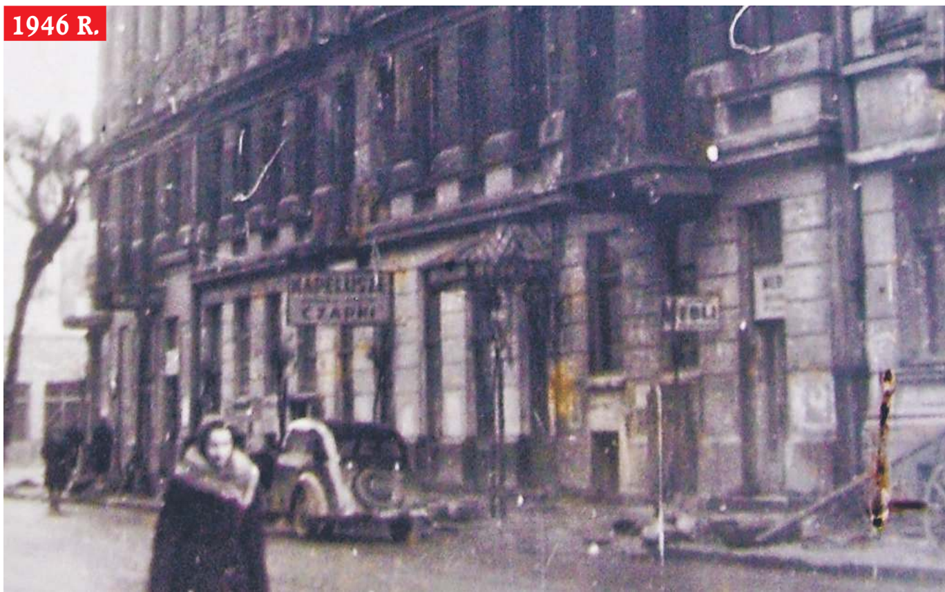
Kamienica przy ul. Marszałkowskiej 63 przed zburzeniem. Akta BOS. Zbiory Archiwum Państwowego w Warszawie | fot. mat. pras./d
