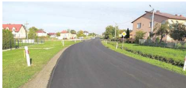
Na początku listopada zakończą się roboty drogowe na odcinkach obejmujących gminy: Biszczu, Potok Górny i Obsza
