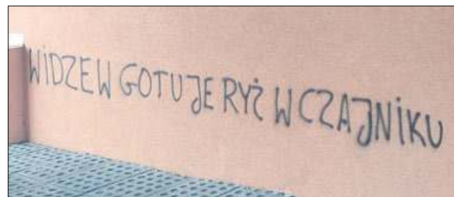
Ktoś oszpecił nową elewację jednego z budynków przy ulicy Górnej w Zdzieszowicach.
