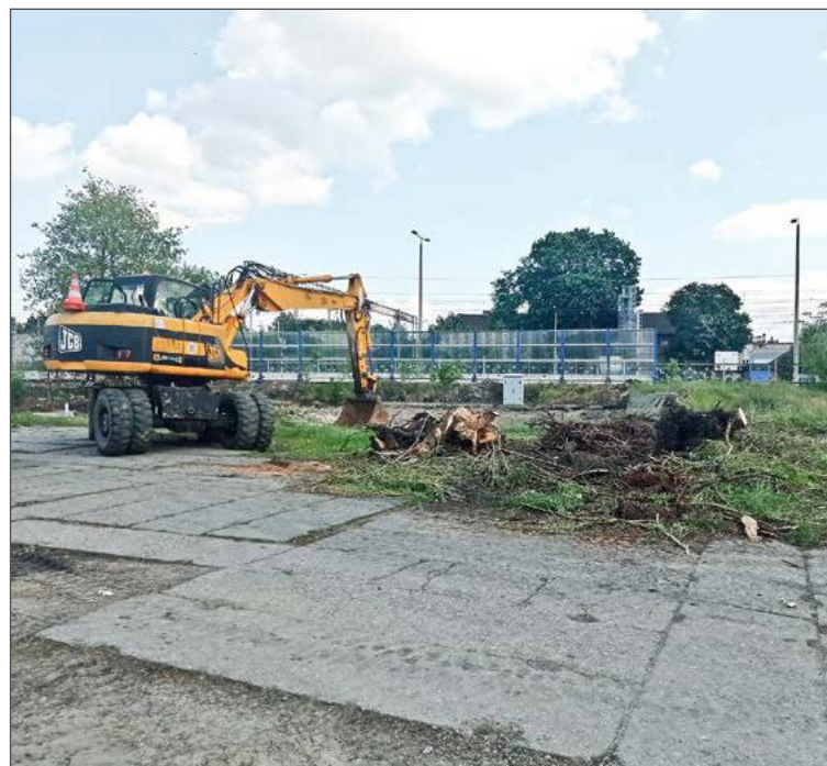
Drzewa wycięte, trwa oczyszczanie terenu.
