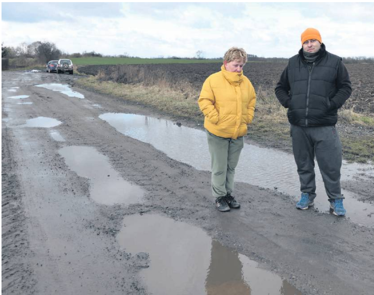
Krzysztof i Wioletta Gruszeccy od lat zabiegają o utwardzenie drogi, która prowadzi do ich domu
