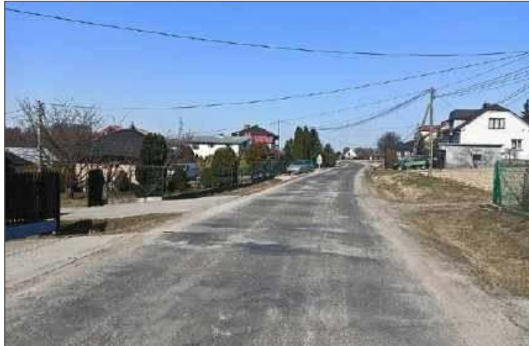
Remontowany ma być m.in. odcinek drogi przez Stasiówkę.
