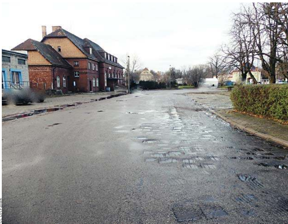
Dzięki trwającej inwestycji, zmieni się otoczenie pasłęckiego dworca
