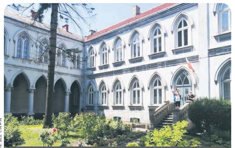
Dzięki wsparciu z budżetu województwa mazowieckiego w Świątyni Miłosierdzia i Miłości oraz budynkach klasztoru Mariawitów w Płocku zamontowana zostanie instalacja sygnalizacji pożaru
