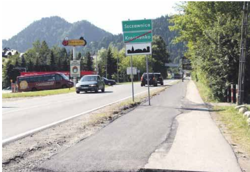
Jest już nowy asfalt na ścieżce pieszo-rowerowej w Szczawnicy.
