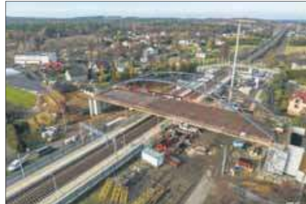
Wiadukt w Ciężkowicach
