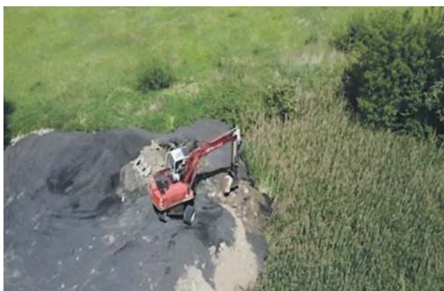
... jego zasypywanie na prywatnych działkach przy ul. Prusa w Alwerni
