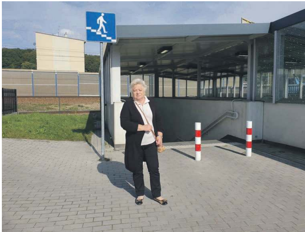
Przewodnicząca osiedla Parkowego Irena Godyń przy zalanym przejściu podziemnym
