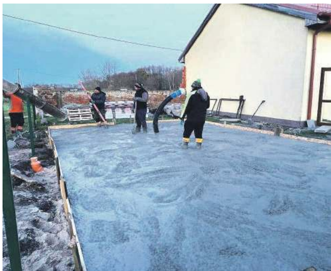
Zakończył się pierwszy etap prac związany z budową szatni kontenerowych w Krościnie Wielkiej, teraz czas na kolejny etap
