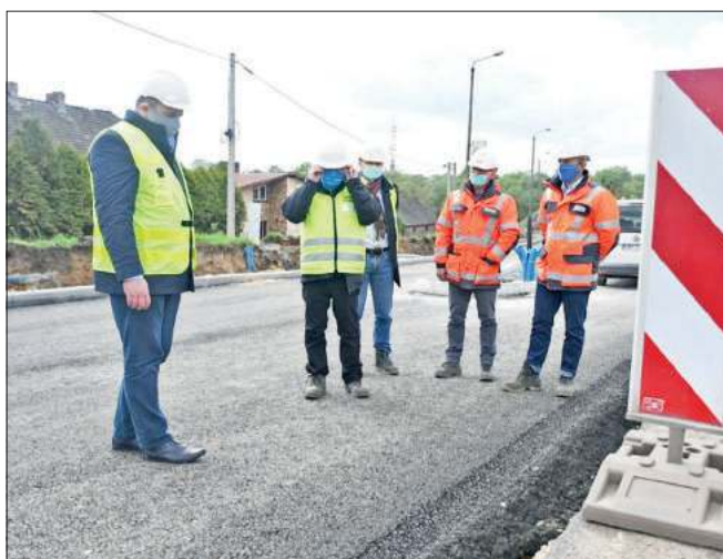
Marszałek Jakub Chełstowski w ostatnich dniach odwiedził m.in. plac budowy na DW 933 w Wodzisławiu. Fot. Patryk Pyrlik/UMWS
