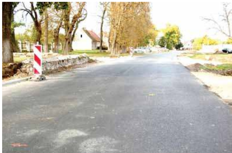
Trwa przebudowa drogi na odcinku Rzeplino-Krępcowo. Niesprzyjająca pogoda jest powodem opóźnień w wykonaniu prac
