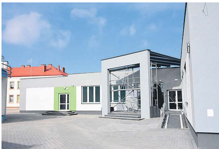
Widok od strony parkingu na wejście do przedszkola.
