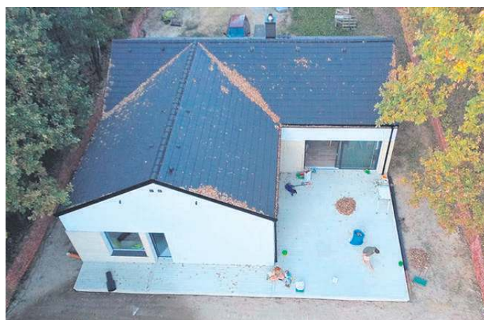
Zrealizowany projekt domu pasywnego.
