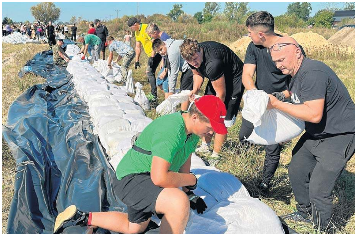
W Kostrzynie nad Odrą w wielu miejscach trzeba było budować wały od podstaw
