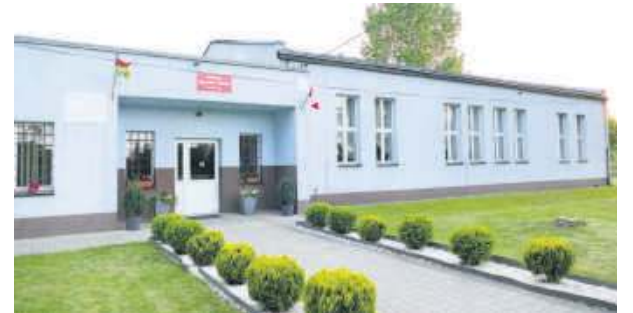
Inwestycja obejmie m.in. naprawy tynkarskie, malowanie, modernizację schodów zewnętrznych i drzwi ewakuacyjnych
