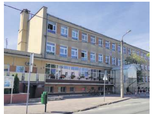
W ramach inwestycji kompleksową termomodernizację przejdzie między innymi Szkoła Podstawowa nr 4 w Strzelinie
