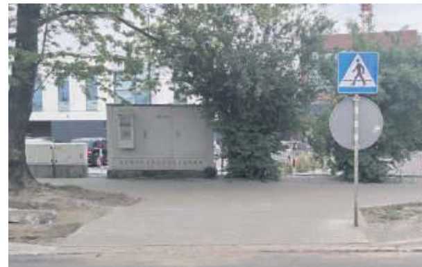
Tak oznakowane przejście dla pieszych to tylko ułańska fantazja jakiegoś dowcipnisia
