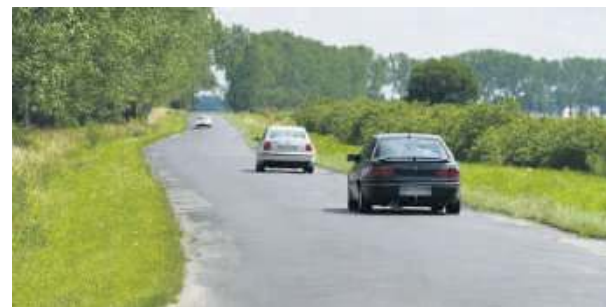
Remont będzie obejmował odcinek od prostowanego zakrętu w kierunku Jegłowej
