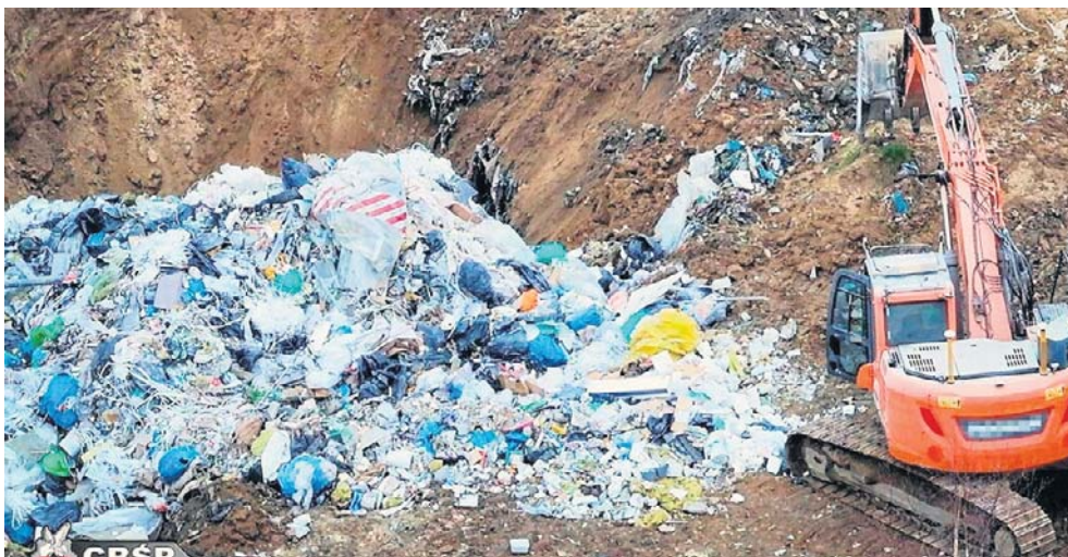
Odpady były zrzucane i zakopywane nocą przy użyciu ciężkiego sprzętu pracującego bez oświetlenia
