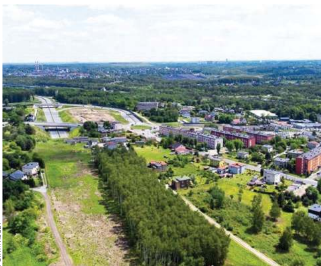
Teren, na którym wybudowany będzie końcowy odcinek Drogi Regionalnej
