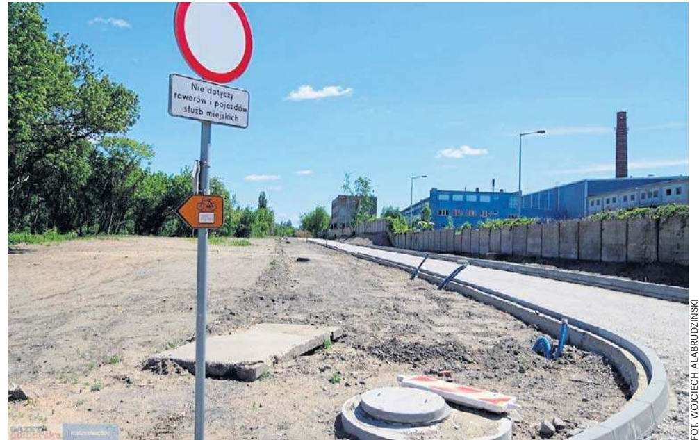
Nowa droga połączy bulwary z terenem, na którym miasto chce zbudować Szkutnię
