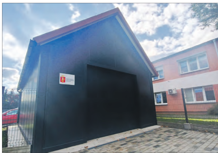
Nowy garaż przy PCPR w Prudniku
