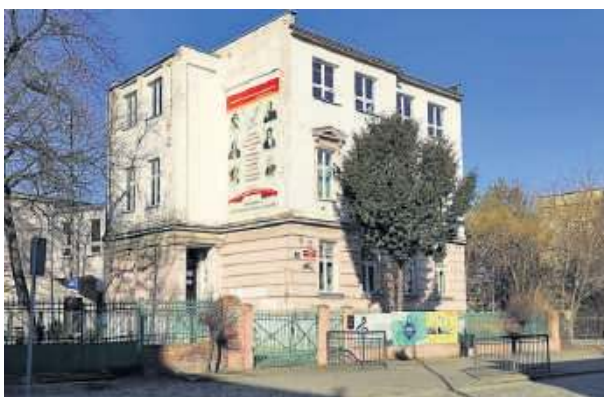
W ramach projektu budynek Szkoły Muzycznej I stopnia w Strzelinie ma przejść kompleksową termomodernizację
