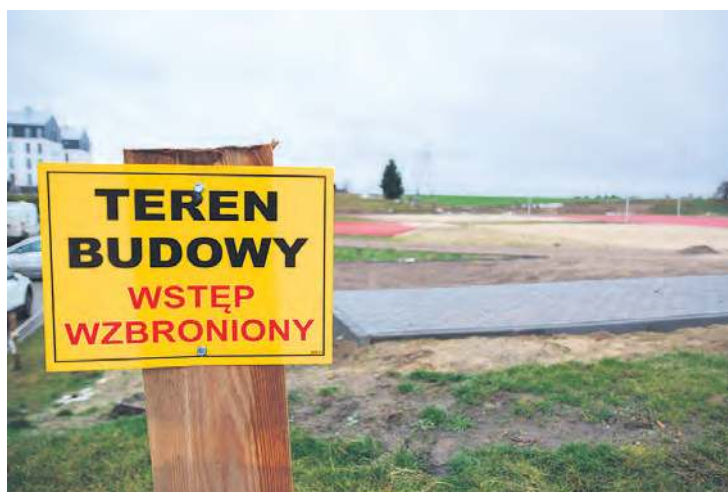
Radni gminy Cekcyn zwiększyli na ostatniej sesji środki na realizację zadania przy budynku dawnego gimnazjum. Inwestycja będzie kosztować nie ponad 1,8 mln zł, ale 2,1 mln zł.
