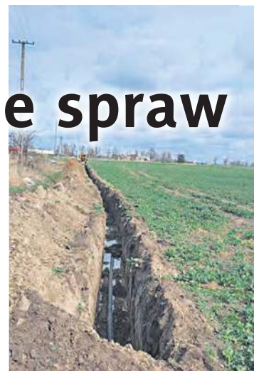
Trwa budowa wodociągu.
