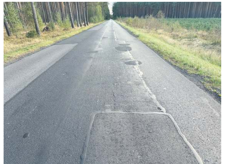
Jeden z fragmentów drogi, na którym, jak widać, trwają prace doraźne. Fot. (kt)
