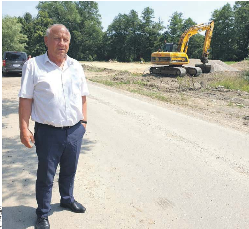
Prezes WiK Henryk Skotniczny na placu budowy nowej siedziby spółki
