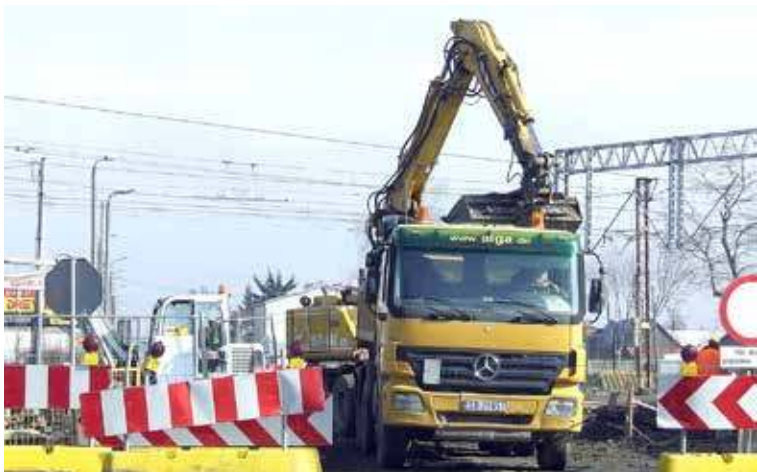
Prace na przejeździe kolejowym w Pilawie
