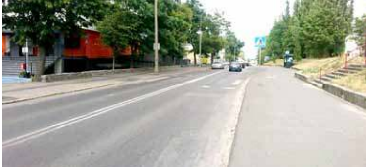
Koszt przebudowy ulic Pierwszej Brygady i Marii Konopnickiej oszacowano na 3,6 mln zł
