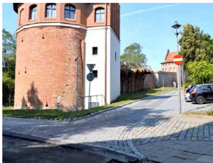
Trwa przebudowa ul. K. Wielkiego w związku z tym ulica Sukiennicza została wyłączona z ruchu.
