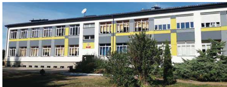
Budynek Szkoły Podstawowej w Kinkajmach po termomodernizacji
