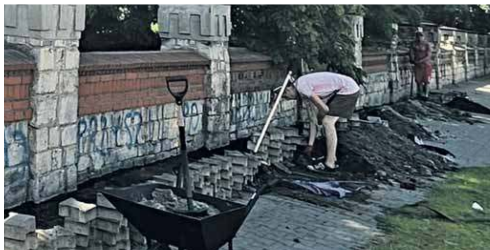
W Nakle Śląskim trwa właśnie remont ogrodzenia przy CEKUŚ. To efekt wygranej w ubiegłorocznym budżecie partycypacyjnym powiatu. Autorami projektu są Jarosław Wasząnik – przewodniczący rady gminy Świerklaniec oraz Ilona Jaworska-Kapica, prezes Stowarzyszenia Miłośników Nakła Śląskiego im. Jana Bursiga
