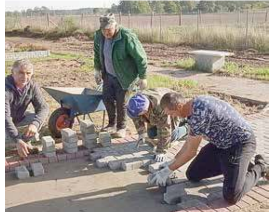
Prace wykonano na przestrzeni ostatnich dwóch miesięcy
